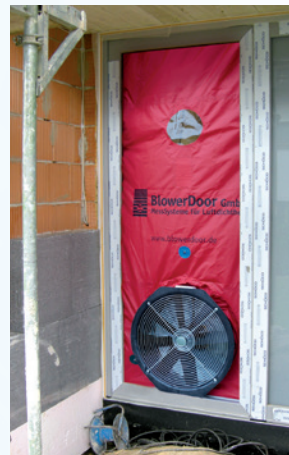
BlowerDoor Messung eines neu gebauten Einfamilienhauses
