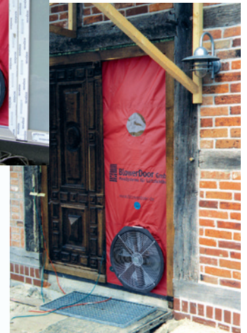
BlowerDoor Messung im Rahmen einer Fachwerksanierung
